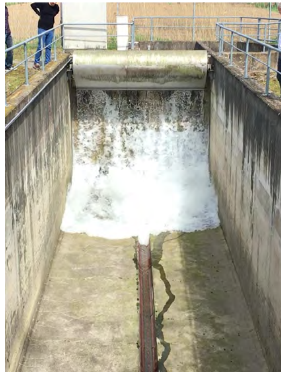
Abb.: Einsatz einer Spülkippe im Regenüberlaufbecken
