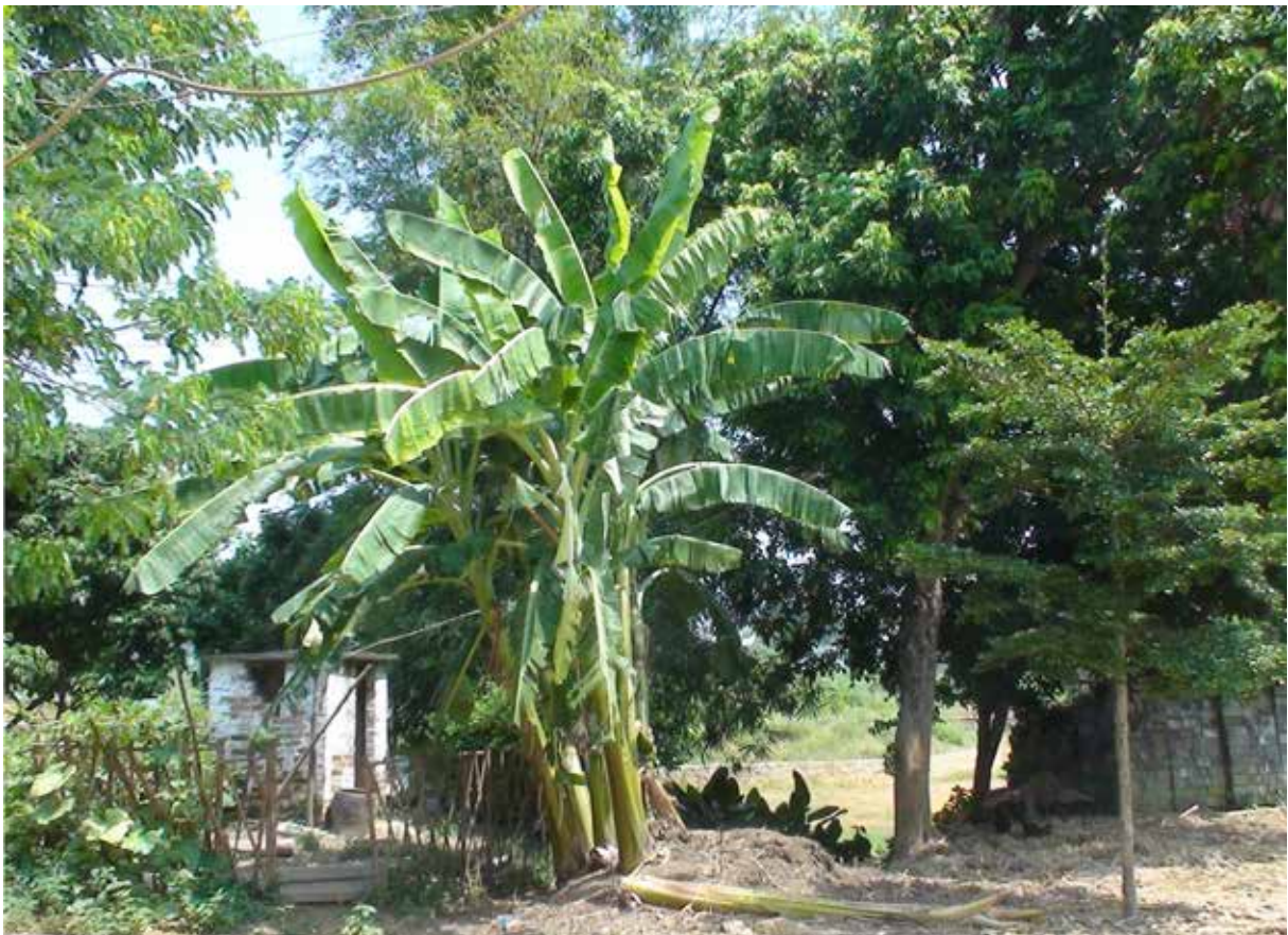
Dezentrale Biogasanlage mit Toilette in einem Dorf bei Nanning, Guangxi, China
