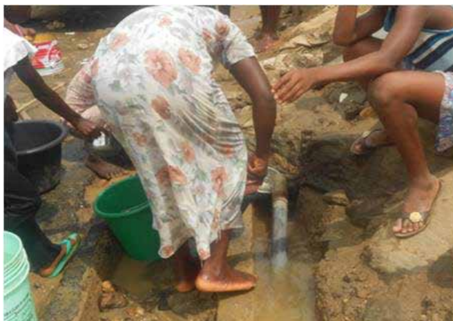
Abb.: Selbsthilfe an einer Leckstelle der Wasserleitung
