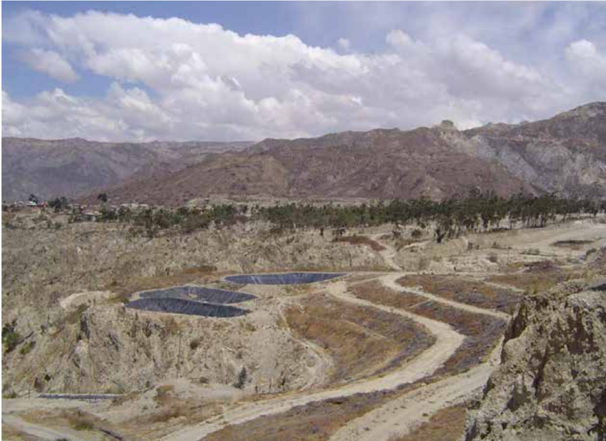
Deponie mit Sickerwasserteichen in La Paz
