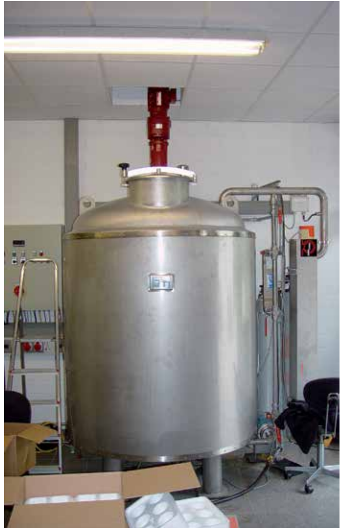
Edelstahltank (2,1 m 3 ) zur Pasteurisierung von Abwasser, Grund- und Trinkwasser
