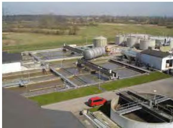
Abb.: Vorklärbecken, Blockheizkraftwerk und Biogas-anlage der Gemeinschaftskläranlage Baden-Baden - Sinzheim
