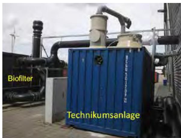
Bypassleitungen (links) zu den alternativen Abgasreinigungssystemen (rechts)
