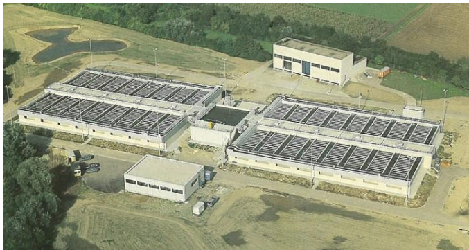
Abbildung 1: Luftbild des Filterbauwerks aus dem Jahr 1986
