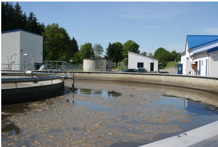
Abbildung 1: Kombi-Becken der Kläranlage Emmingen (außen: Belebung, innen: Nachklärung)
