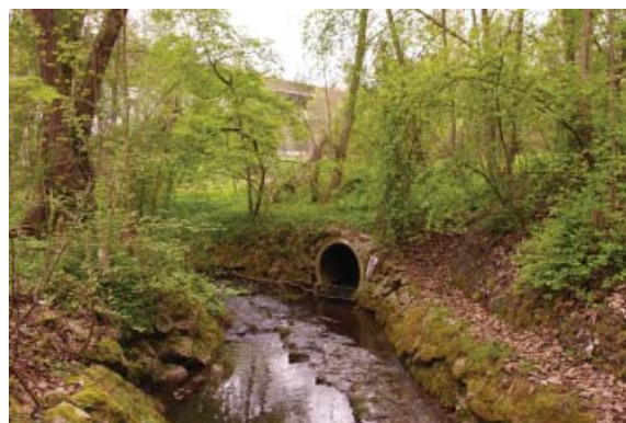
Abb.: Einleitstelle bei Trockenwetter
