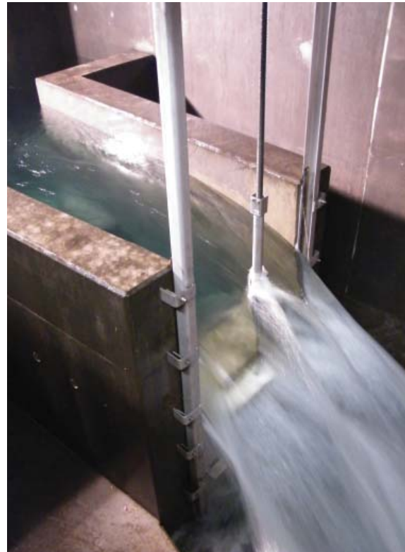
Abb.: Klarwasserabzug der Behandlungsanlage RFM Haid nach Regenende
