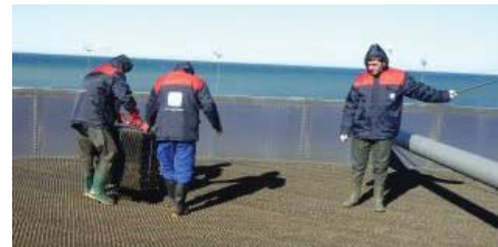
Abbildung 2: GEA 2H Füllmaterialuntersuchung an einem TK in Batumi (Georgien)
