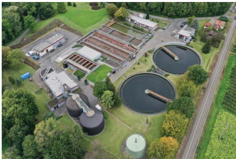
Abb.: Bild der Kläranlage Eriskirch (Bildquelle: Abwasserverband Unteres Schussental)
